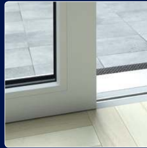
Barrierefrei Eingelassene Bodenschwelle statt Stolperfalle.
